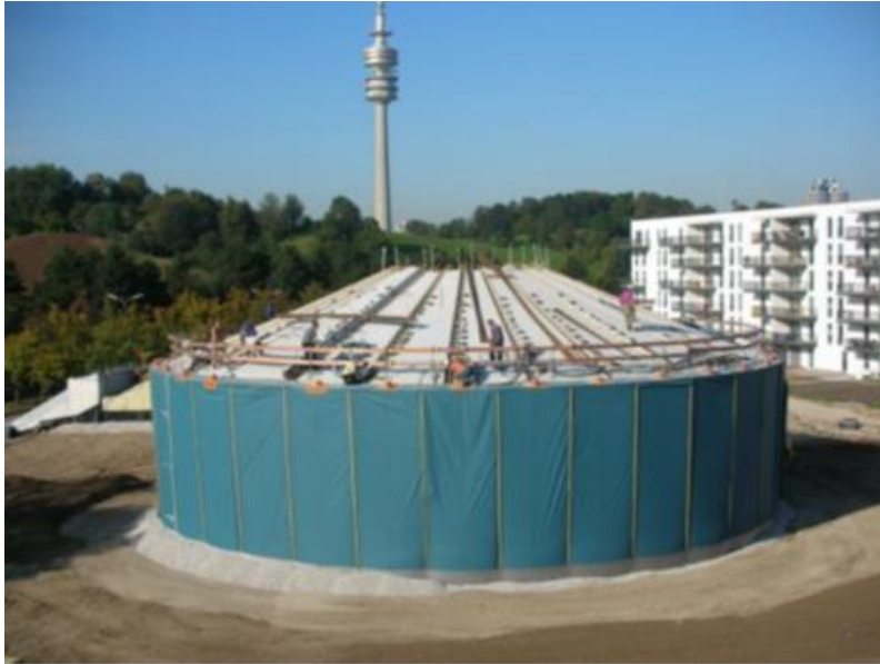
Joonis 4.18. Paak-soojussalvesti ehitamine
