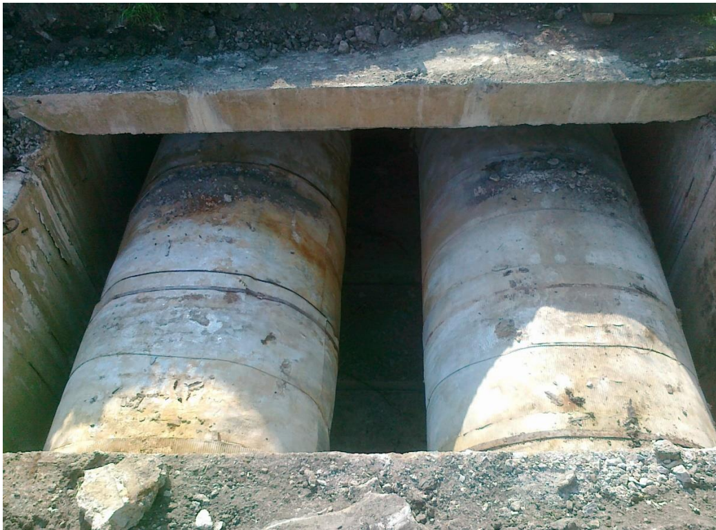
Joonis 2.3. Laagna soojusmagistraal enne renoveerimist (allikas: Utilitase arhiiv)
